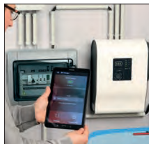
La borne de recharge communique en Wifi ou Bluetooth. Clavier à code avec badges RFID fournis. Paramétrage du clavier via logiciel fourni.
