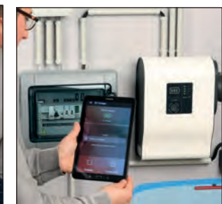
La borne de recharge communique en Wifi ou Bluetooth. Clavier à code avec badges RFID fournis. Paramétrage du clavier via logiciel fourni.
