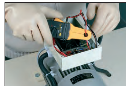
Recherche de panne en condition réelle sur le bornier moteur.
