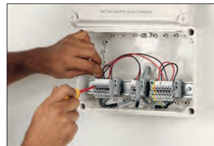
Câblage de la commande et des composants sur BORNELEC1-M (boîtier en face arrière)
