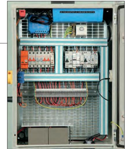
Coffret batterie + régulateur de charge.
