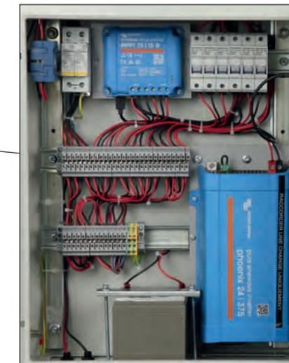
Coffret batterie + régulateur de charge.
