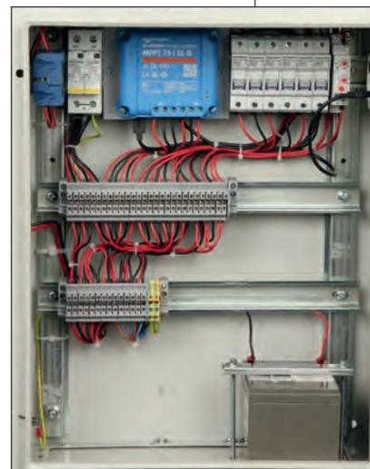
Coffret batterie + régulateur de charge.
