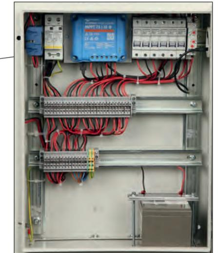
Coffret batterie + régulateur de charge.
