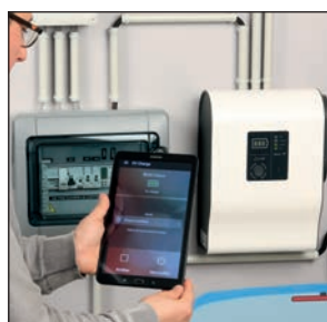
La borne de recharge communique en Wifi ou Bluetooth. Clavier à code avec badges RFID fournis. Prise déportée pour connexion du PC pour la programmation du clavier. Paramétrage du clavier via logiciel fourni
