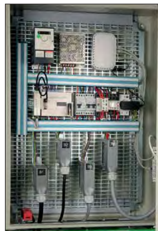
Grille rapidement démontable grâce aux prises Harting®.
